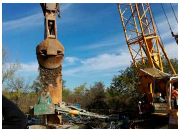
Forage du nouveau puits
