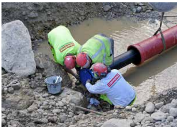
Chantier du passage sous la Gresse
