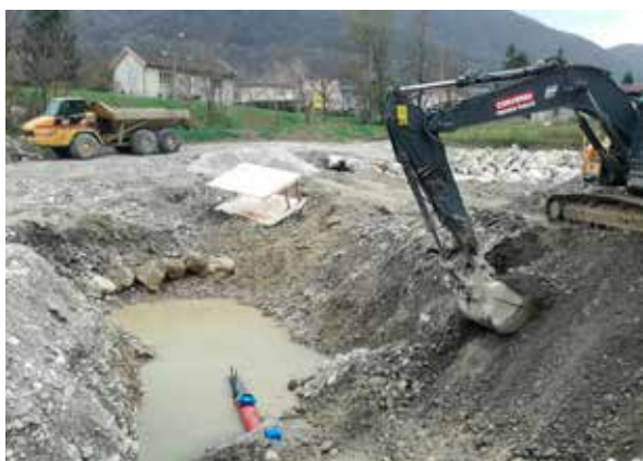
Chantier du passage sous la Gresse
