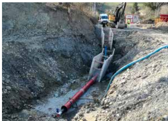
Chantier du passage sous la Gresse
